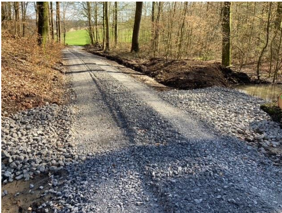
Abb. 3: Eine frisch angelegte Rigole im Gemeindewald Meckesheim (Foto: Kreisforstamt)
